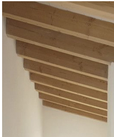
Bigas de madera Wooden beams Holzbalken
